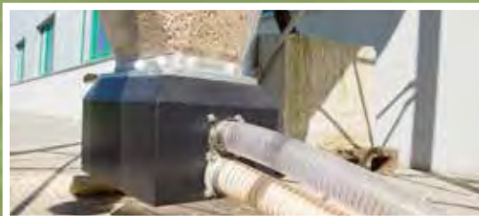
Osztóegység egy pellet kazánhoz.
